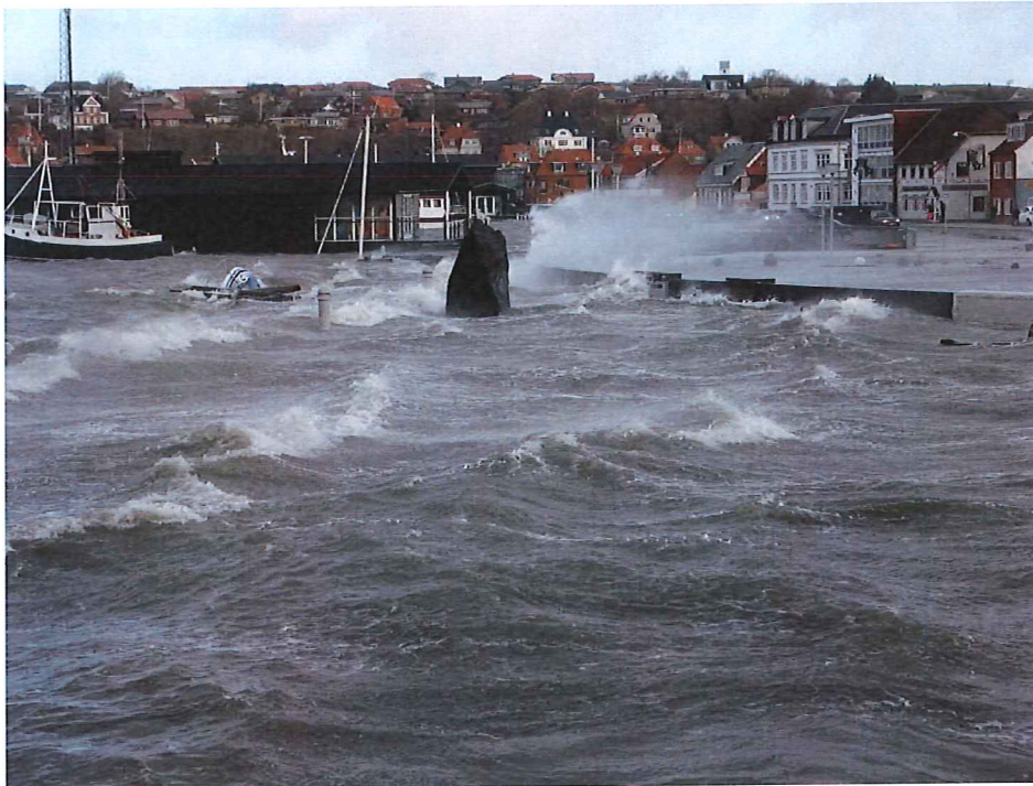
Figur 7.4: Overskyl af højvandsmur i Lemvig (Foto Kystdirektoratet)
