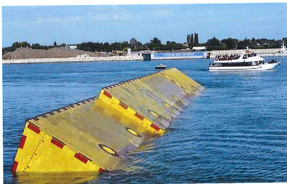
Figur 5.3 Test af de første elementer af slusen ved Venedig
