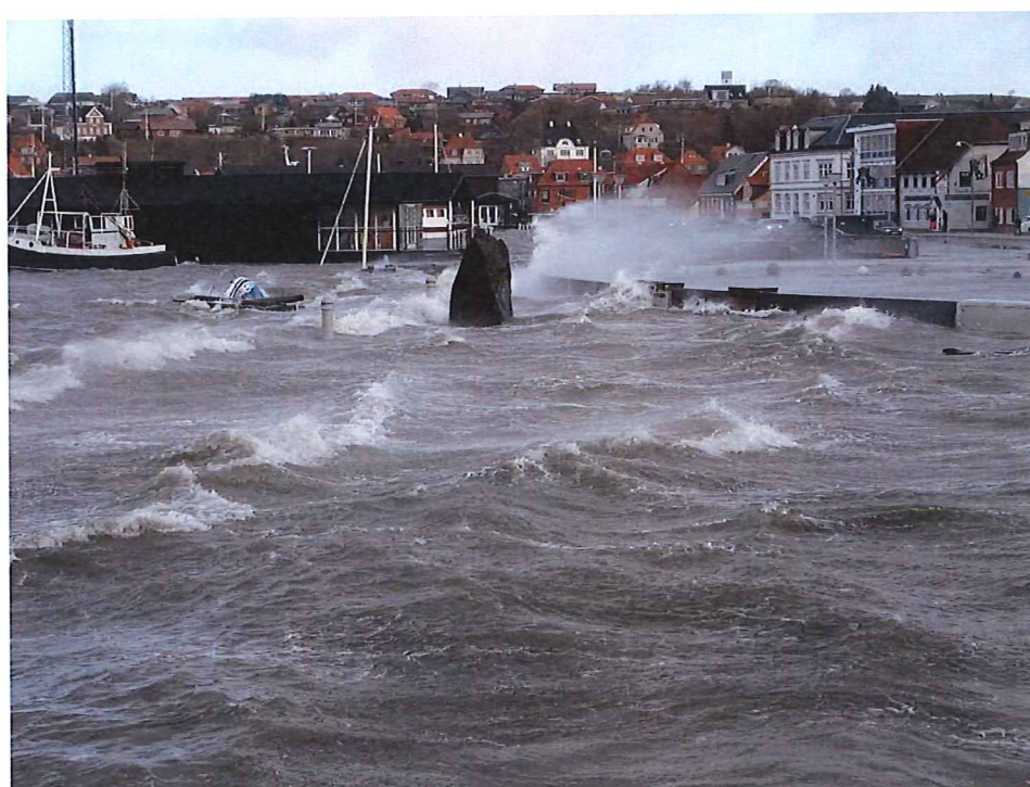
Figur 3.2: Højvandsmur i Lemvig med overskyl fra bølger (Foto Kystdirektoratet)
