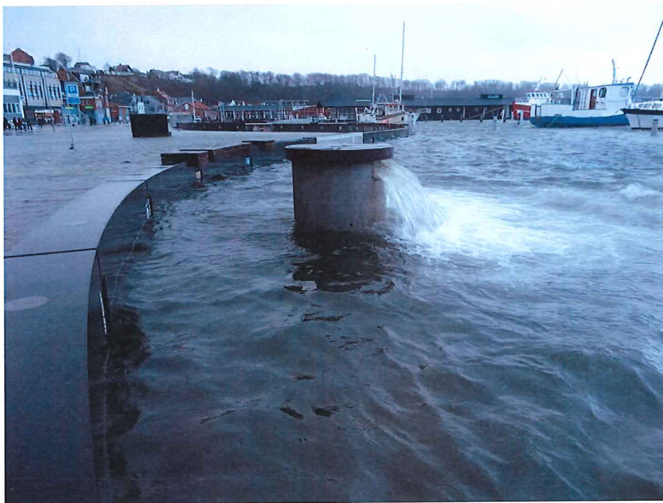
Figur 3.3: Lemvig, lænsning med fast pumpe efter overskyl af muren (Foto Kysdirektoratet)
