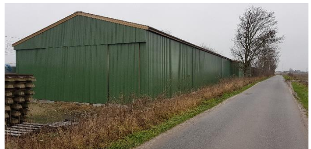
De to store haller beliggende overfor lokalplanområdet.
